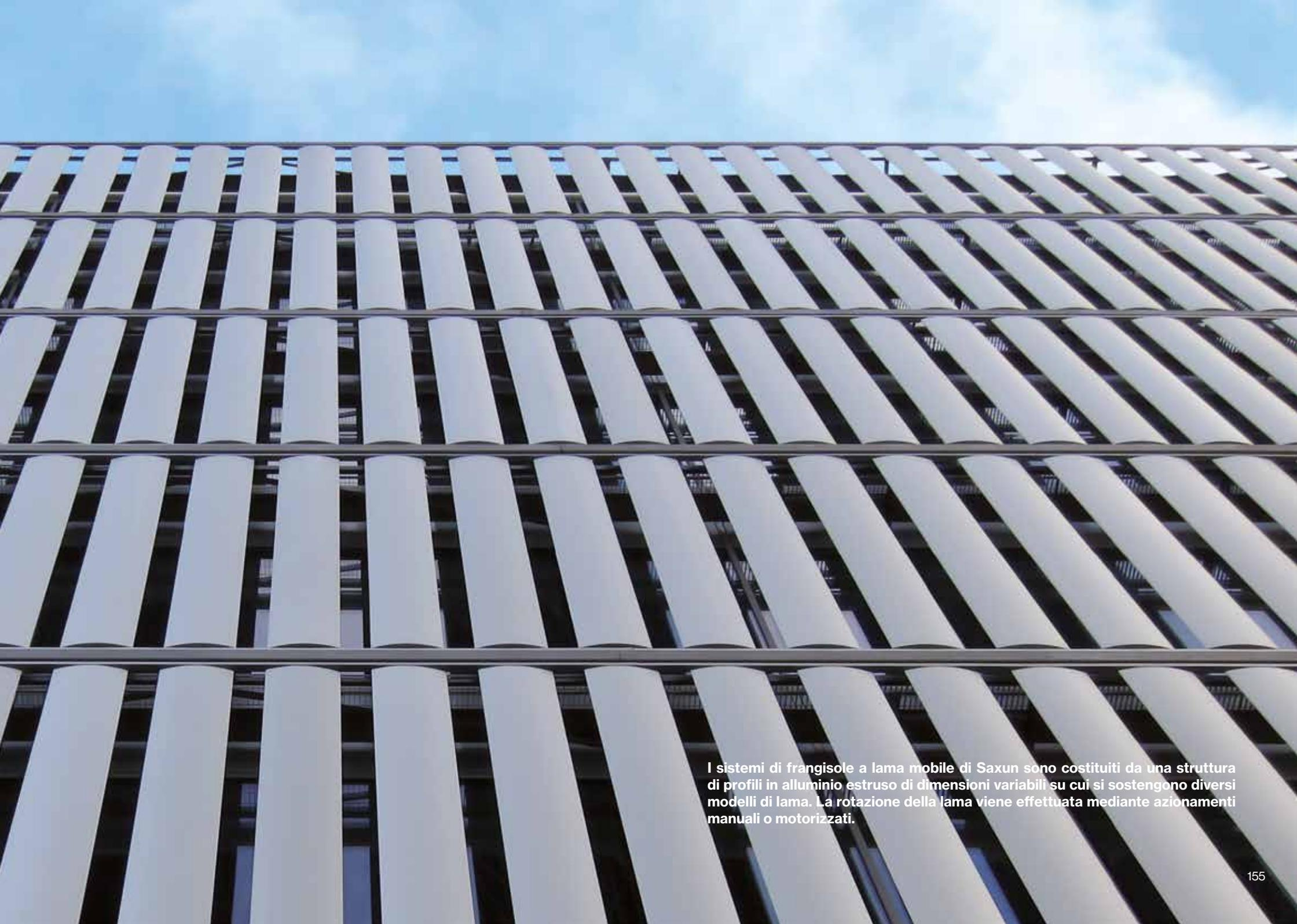
I sistemi di frangisole a lama mobile di Saxun sono costituiti da una struttura di profili in alluminio estruso di dimensioni variabili su cui si sostengono diversi modelli di lama. La rotazione della lama viene effettuata mediante azionamenti manuali o motorizzati.
