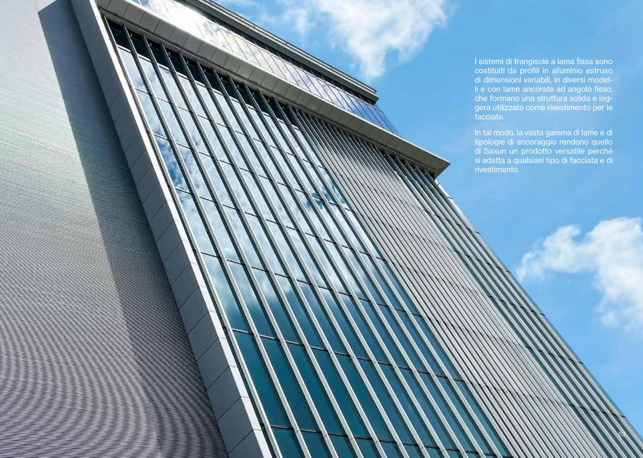
I sistemi di frangisole a lama fissa sono costituiti da profili in alluminio estruso di dimensioni variabili, in diversi modelli e con lame ancorate ad angolo fisso, che formano una struttura solida e leggera utilizzata come rivestimento per le facciate.
